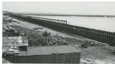
③岸部の壁と土砂を運ぶ鉄管
